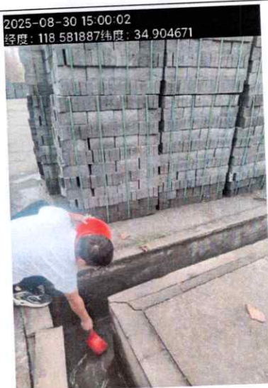
雨水排口现场监测
