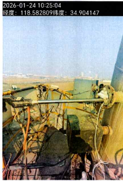
DA015 煅烧炉产生的窑炉烟气现场监测
